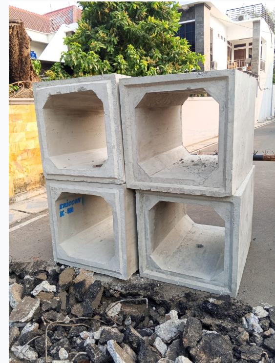
Tumpukan elemen box culvert beton pracetak
