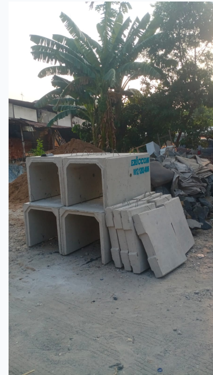
Elemen box culvert tersimpan di area terbuka
