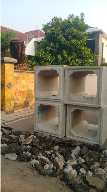
Susunan box culvert di samping material bongkaran
