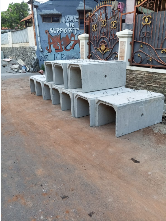
Elemen saluran beton pracetak ditata di tepi jalan
