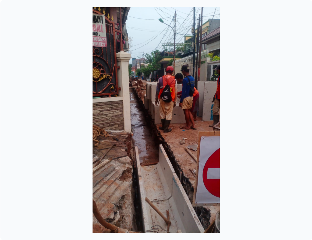
Pekerja dan elemen beton berada di area galian
