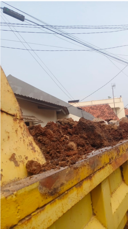
Truk dump mengangkut tanah/material galian
