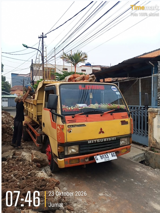
Truk dump pada ruas jalan di area proyek
