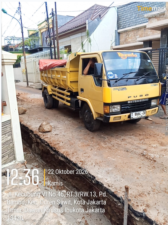
Truk dump dan aktivitas kendaraan di ruas pekerjaan
