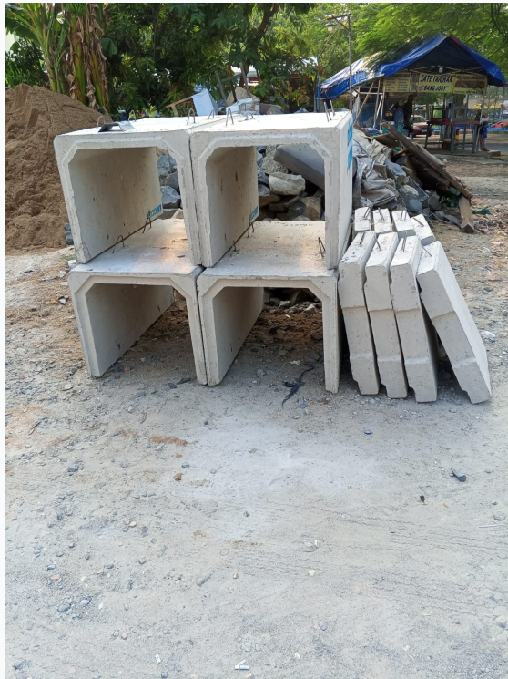
Susunan box culvert dan penutup precast
