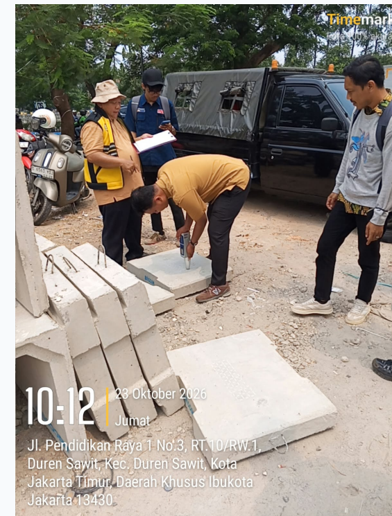
Pemeriksaan elemen pracetak dan pelat penutup
