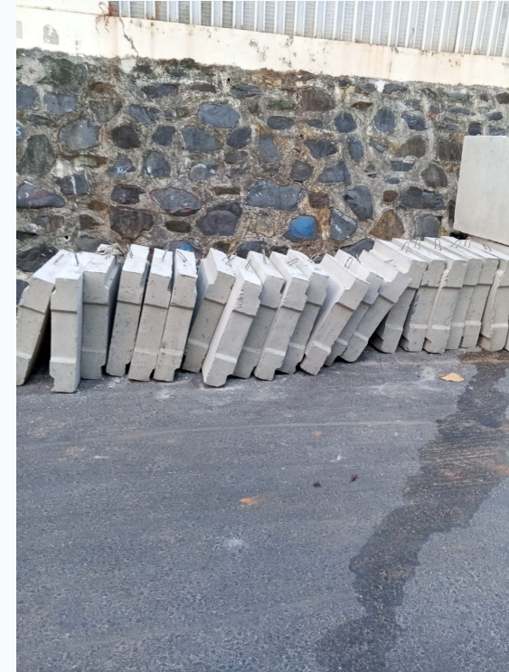
Pelat/penutup beton pracetak ditata di tepi jalan
